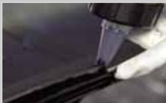
*Отсутствует необходимость в предварительном разогреве при температуре наружного воздуха выше -5°C. Однокомпонентный материал средней вязкости легко наносится с помощью стандартных аккумуляторных пистолетов.*
